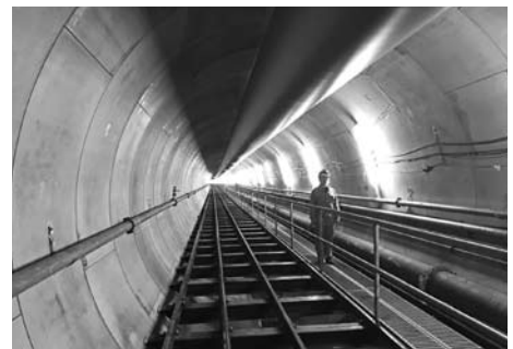
浸水被害への対応のため整備が進む浜田通り貯留管
