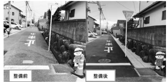
生活に身近な道路整備事業の例（蓋付側溝による路肩拡幅）
