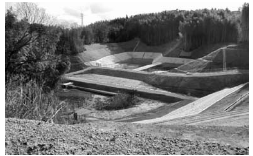
三重県が対策工事を進めている大矢知・平津事案
