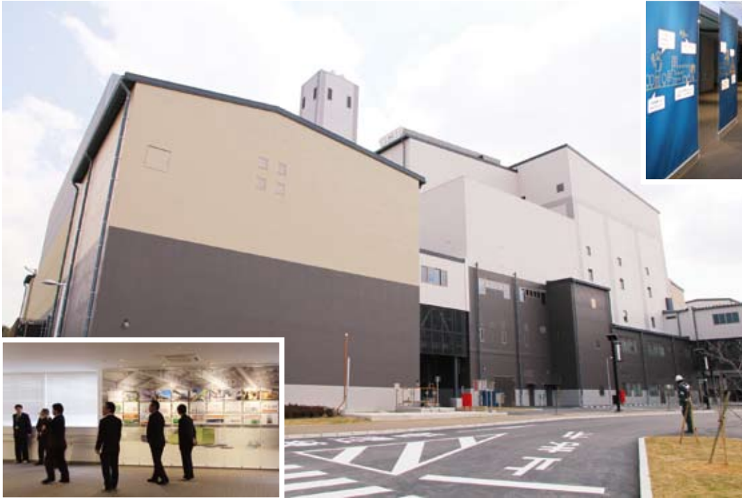
平成28年4月に、焼却施設と破砕処理施設からなる新しい総合ごみ処理施設「四日市市クリーンセンター」が稼働しました。 《右上、左下 管理棟にある見学者展示設備》
