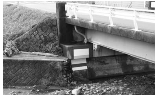
避難勧告などの発令基準となる水位の印（津市危機管理部提供）
