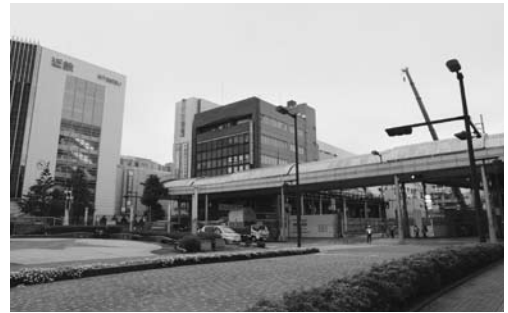
マンション建設が進むジャスコA館跡地
