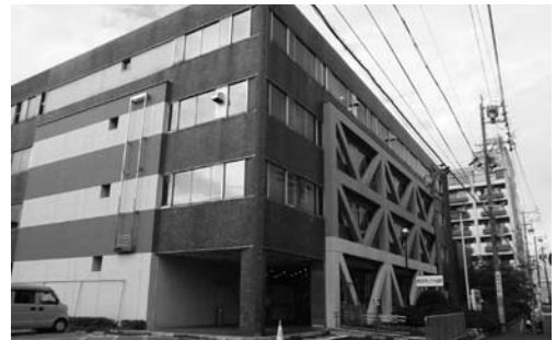
耐震改修工事が完了している上下水道局
