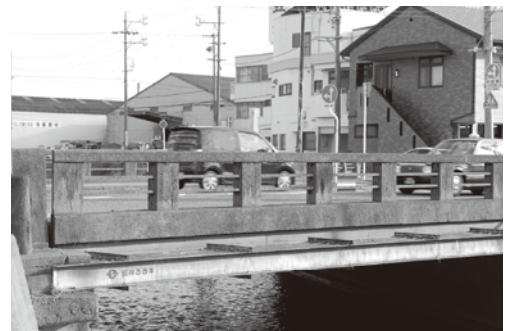
公共インフラは人口減少を見据えた整備が望まれる
