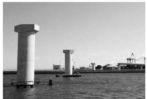
建設中の霞4号幹線（橋脚部分）
