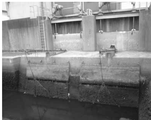
当時の豊栄ポンプ場の樋門
