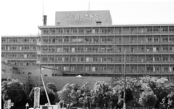
改修が待たれる市立四日市病院
