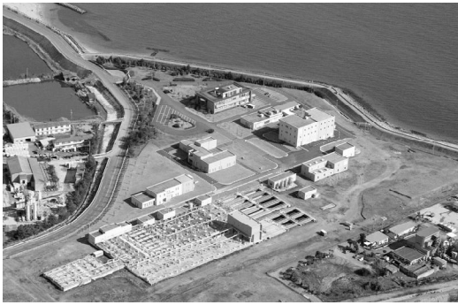
下水道の終末処理施設である南部浄化センター
