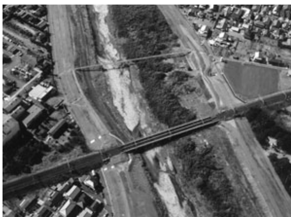
鈴鹿川派川の近鉄橋梁部分(航空写真)
