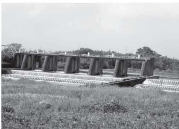
鈴鹿川上流部に設置されている頭首工
