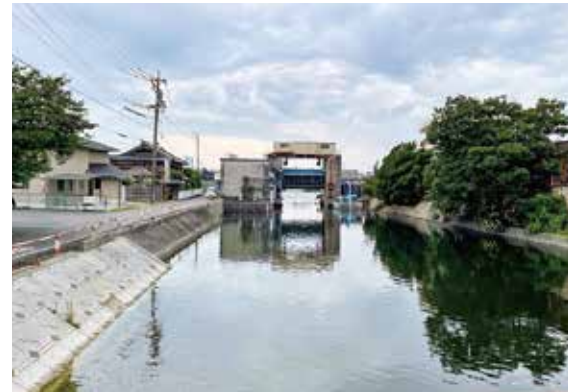
老朽化が進む住吉運河
