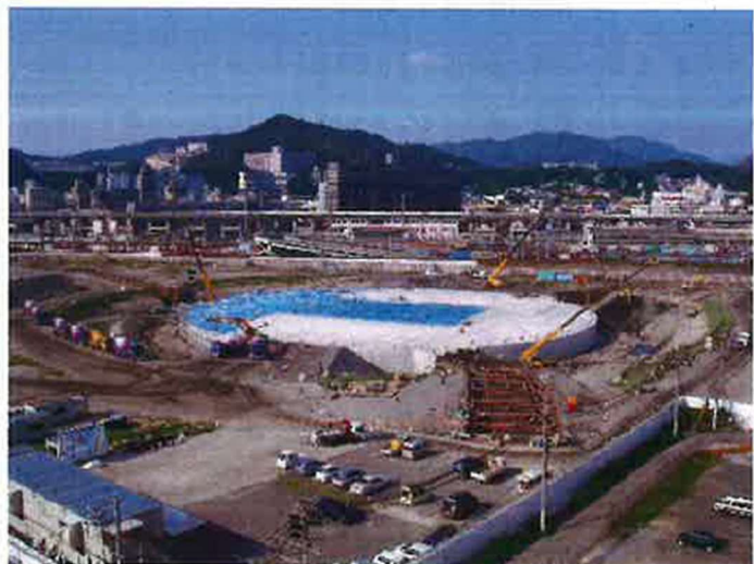
雨水貯留池本体工事状況(H19.9)
