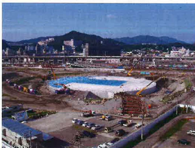
雨水貯留池本体工事状況(H19.9)
