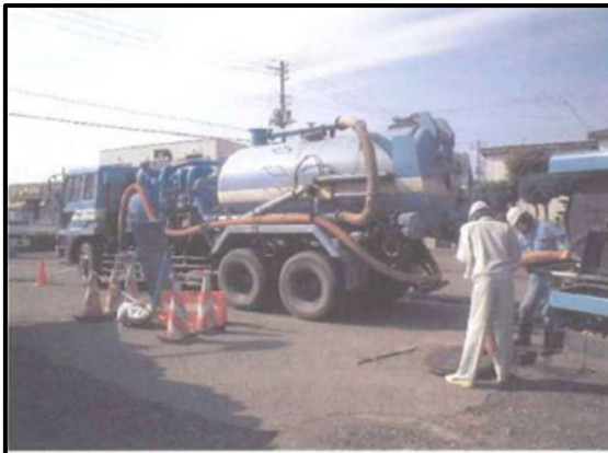
汚泥吸引車による作業状況（参考）
