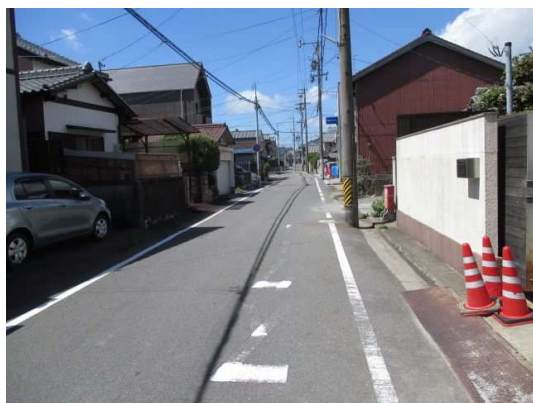
路面表示（施工前）
