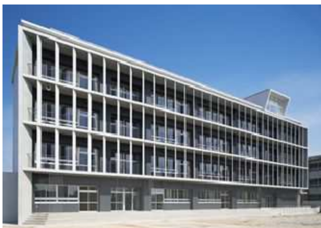
遮光効果 (写真：富田中学校) 夏場の朝の日差しで教室が暑くなるのを防ぐため、バルコニーと縦ルーバーを配置しています。
