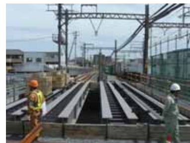
工事が進む近鉄川原町駅周辺の連続立体化
