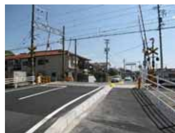
踏切が拡幅された市道日永東日野線
