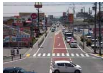
右折レーンをカラー舗装化した 国道1号 日永3丁目交差点
