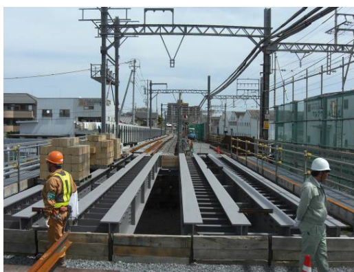
工事が進む近鉄川原町駅周辺の連続立体化
