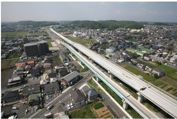
整備が進む北勢バイパス
