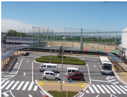
駅のバリアフリー化と合わせて整備された 富田駅西駅前広場
