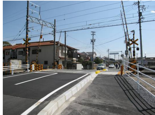
市道 日永東日野線 踏切拡幅
