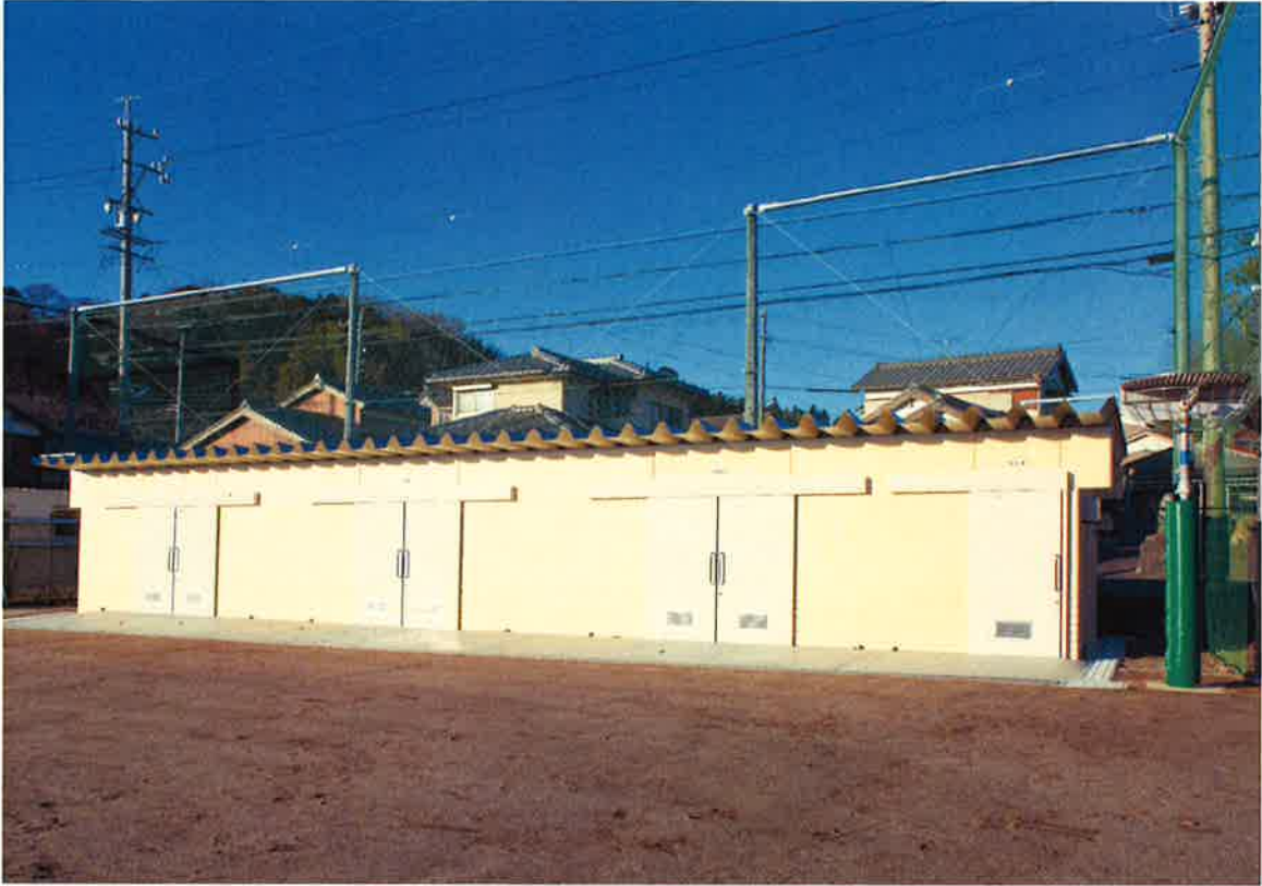
①-2外観(体育器具庫)
