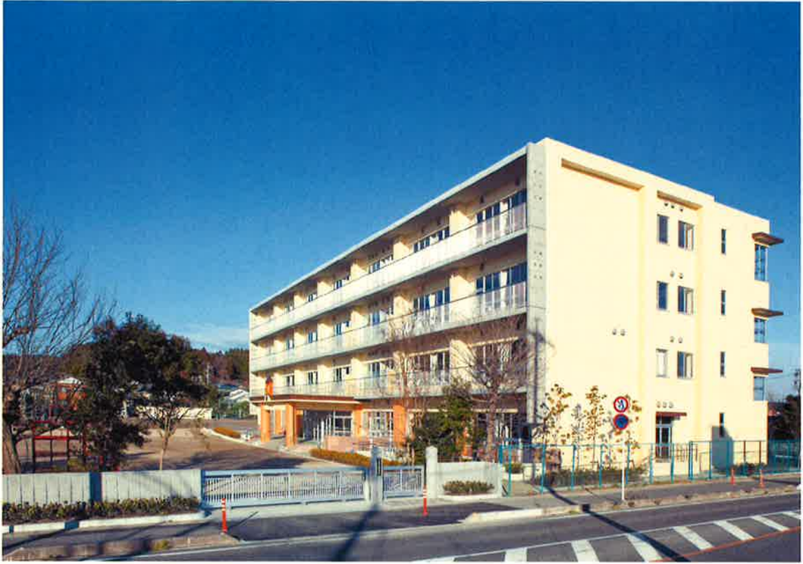
①-1外観(南東方向より)
