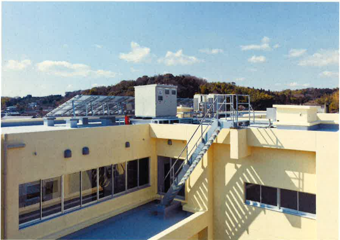
①-1外観(屋上)
