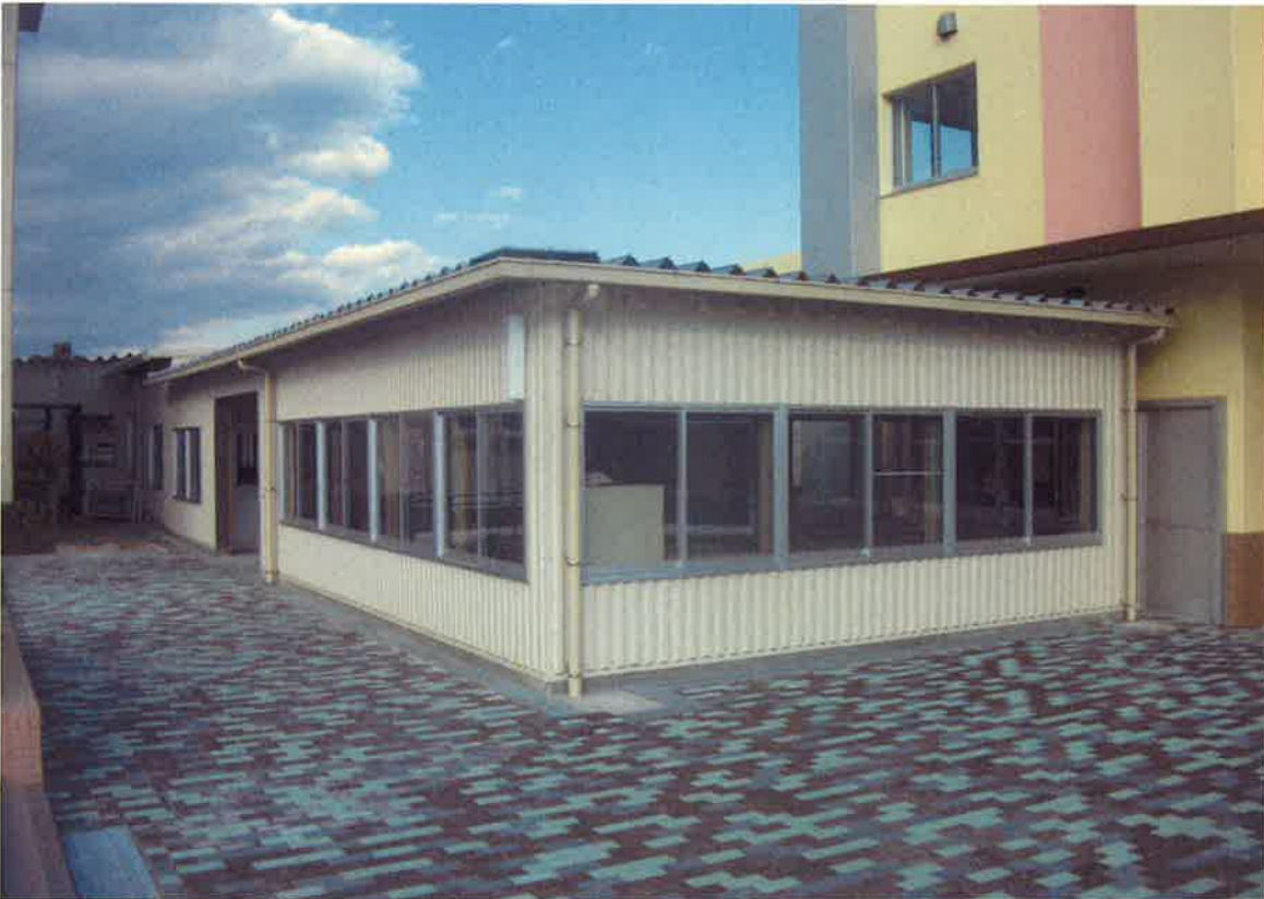
①-1外観(屋上)
