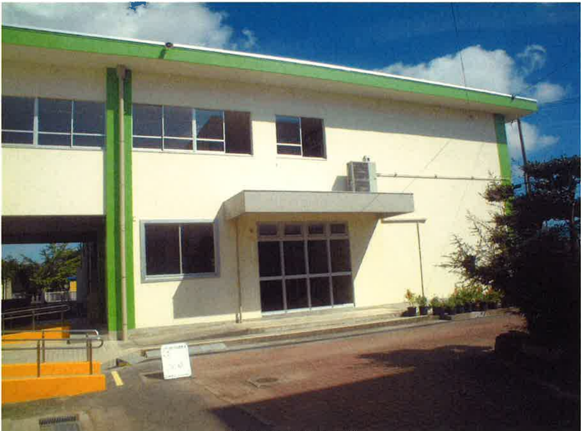
①-2外観(西方向より)
