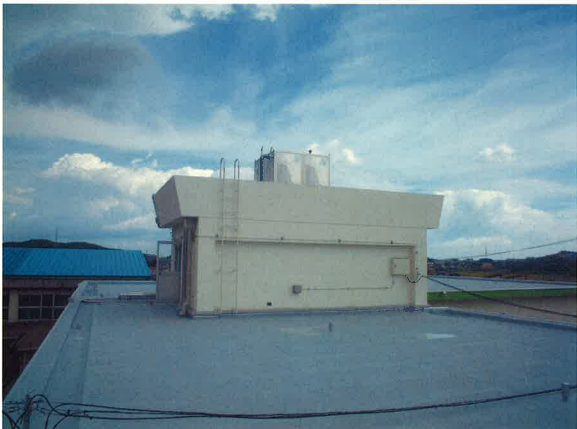
①-1外観(屋上)
