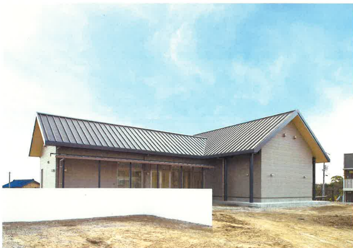
外観(北側から)
