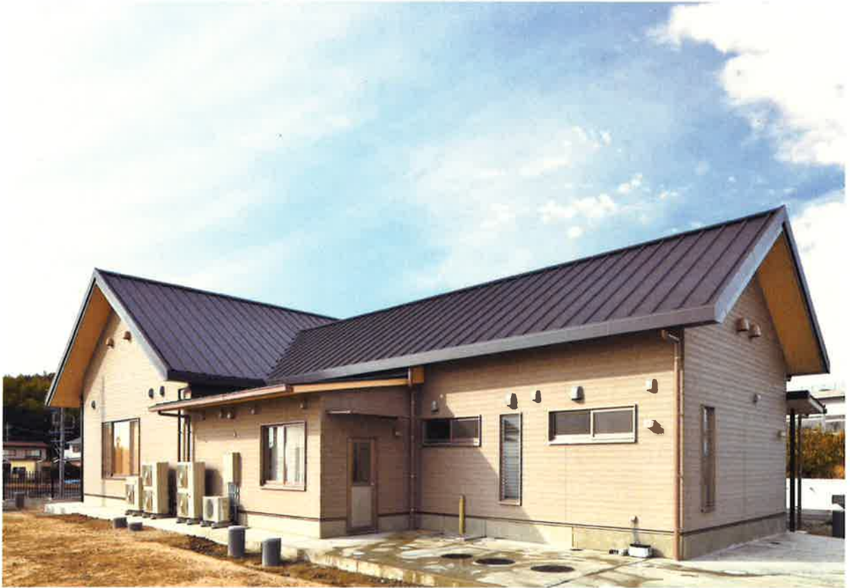
外観(東側から)
