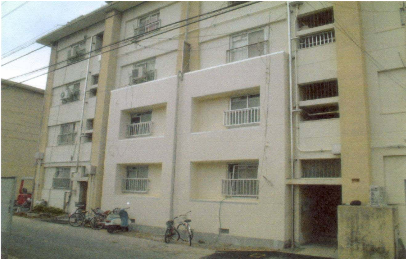
外観 耐震補強部分
