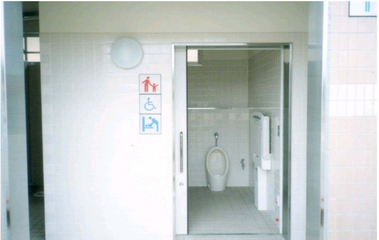
内部 多目的便所
