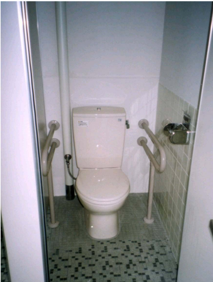
洋式便器 手すり
