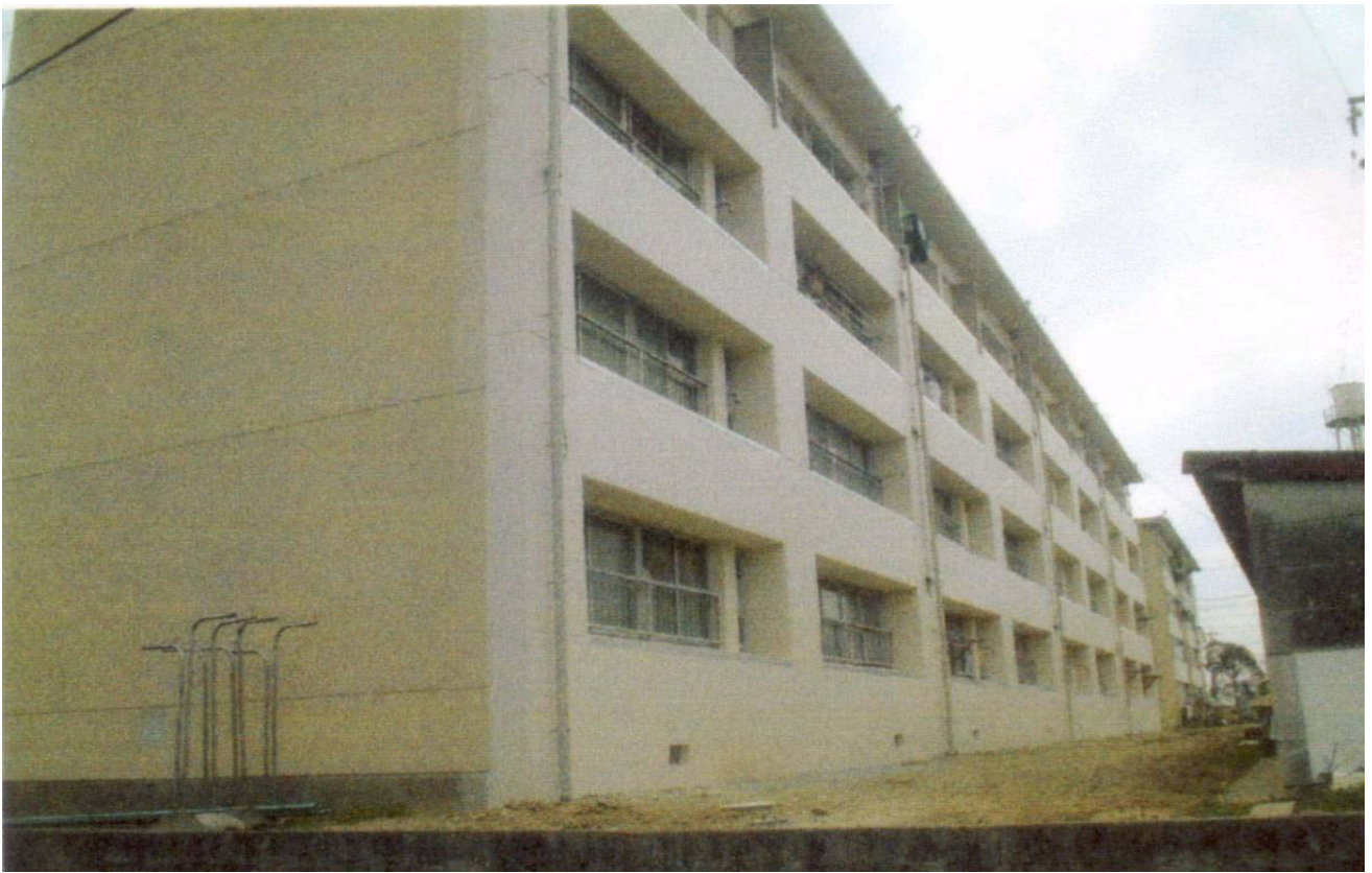
外観 耐震補強部分
