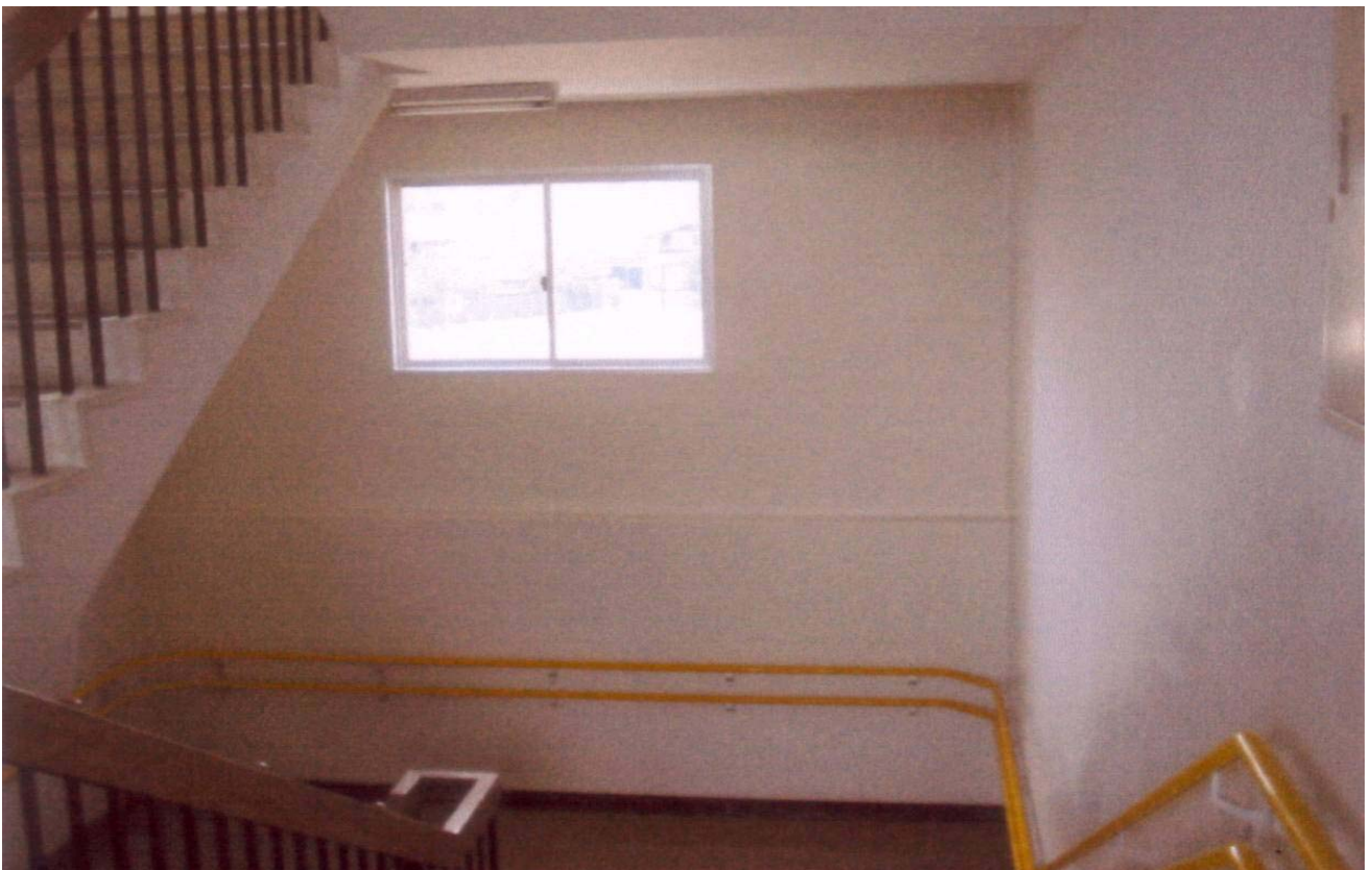
階段室 耐震壁
