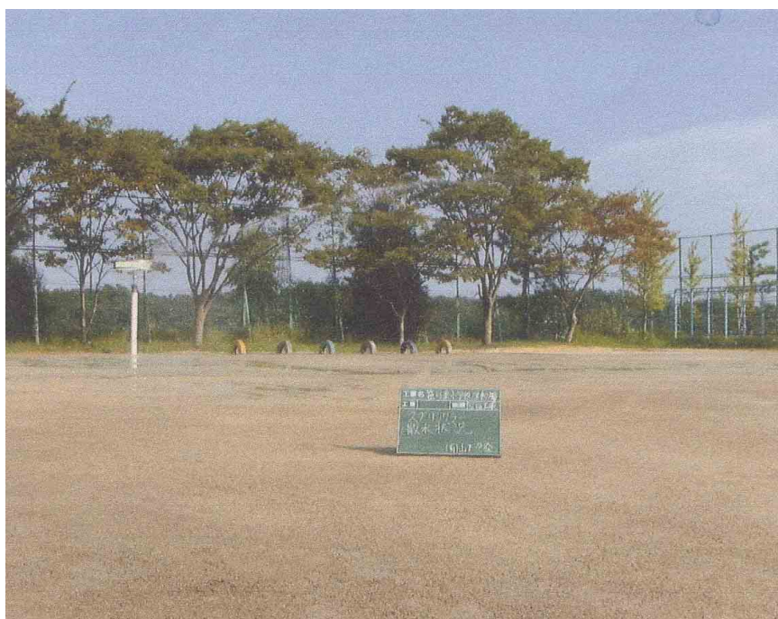
スプリンクラー整備
