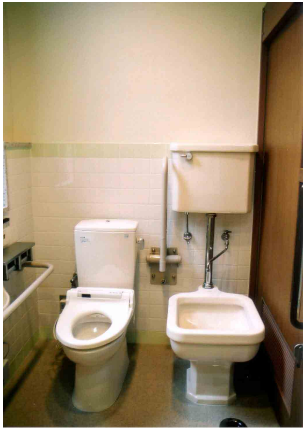
1階 多目的便所
