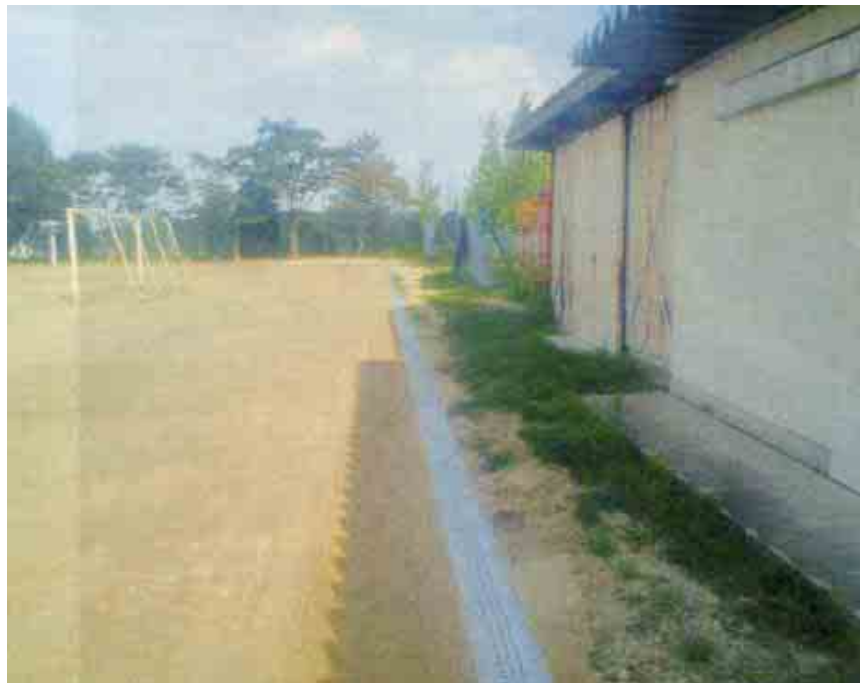
U字溝布設工
