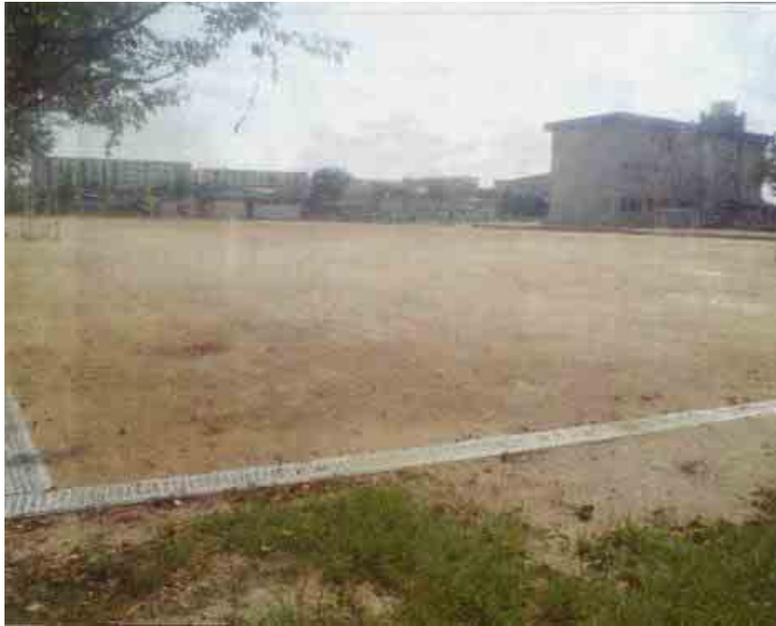
運動場舗装工(真砂土 t=10cm)
