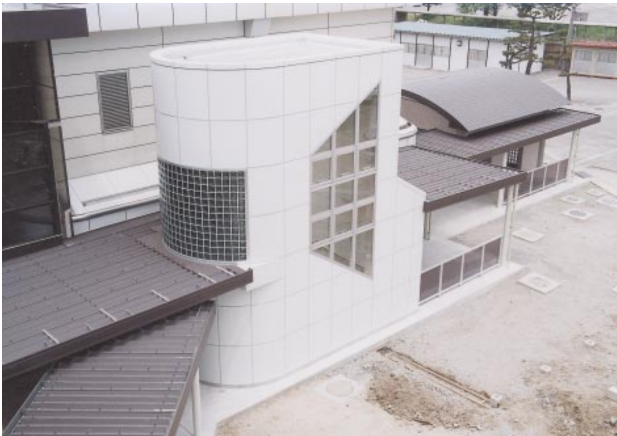
渡り廊下階段室外部東面
