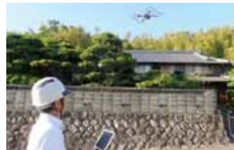
ドローンで災害に備える屋根点検
