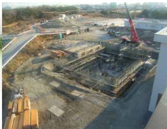
第4系統1期工事
