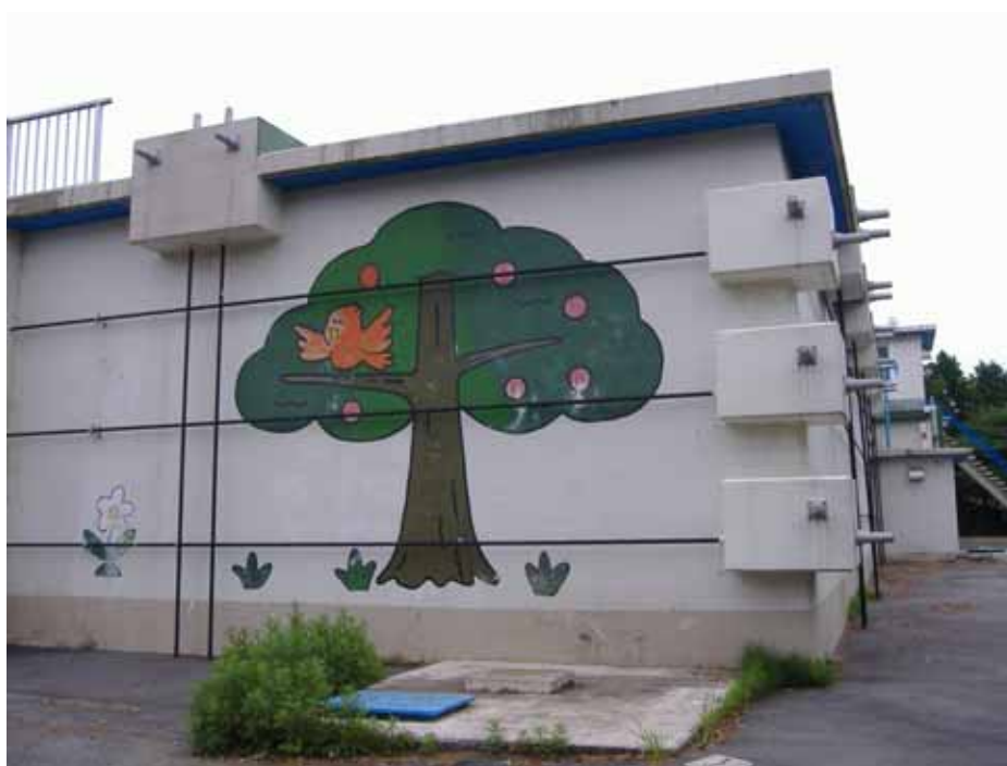
配水池補強工事
