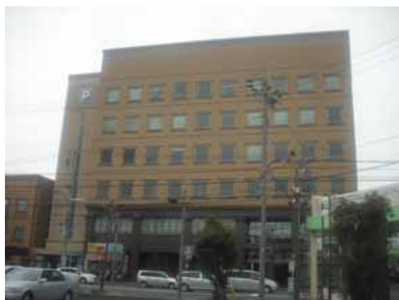
本町プラザ外観
