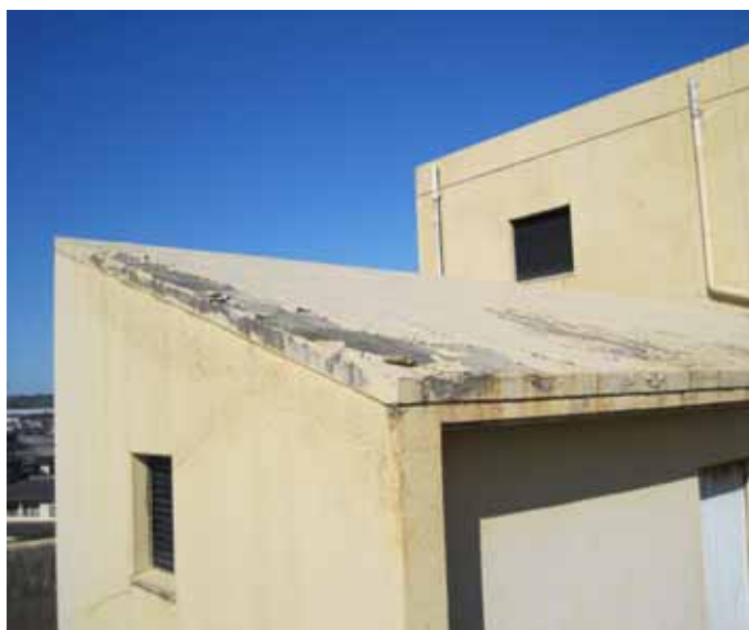
あさけプラザ外壁状況
