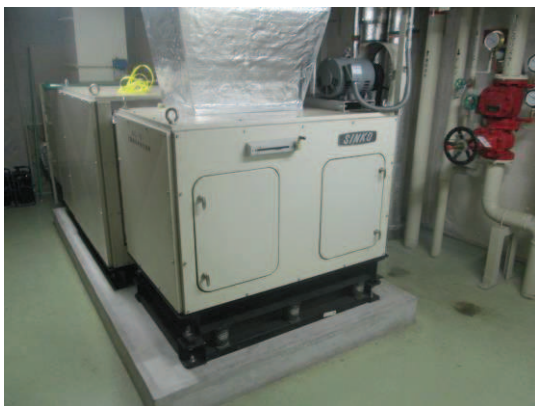
総合会館空調設備更新工事（エアハンドリングユニット）
