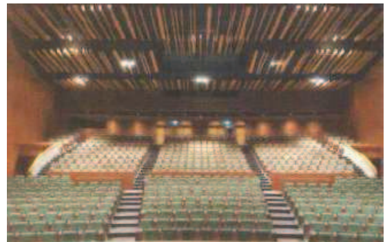
第2ホール吊天井改修後
