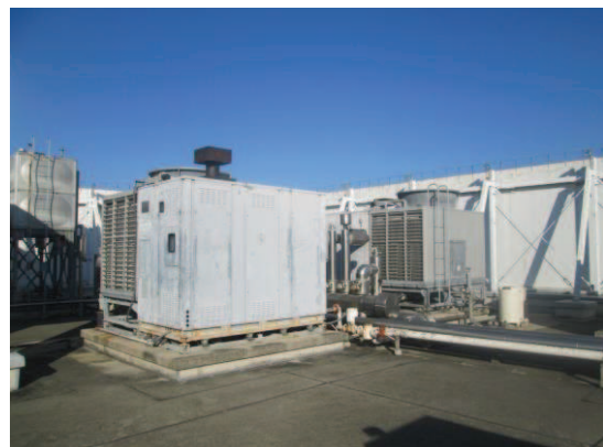
本町プラザ空調設備更新工事（冷温水発生機）
