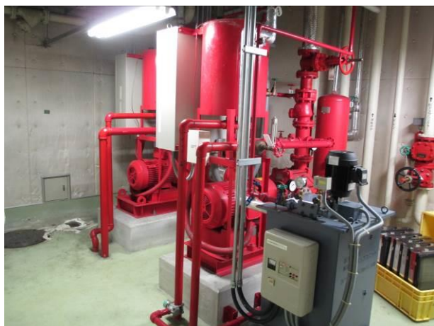
総合会館ポンプ設備更新工事
