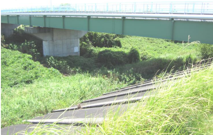
<鈴鹿川派川水管橋>
