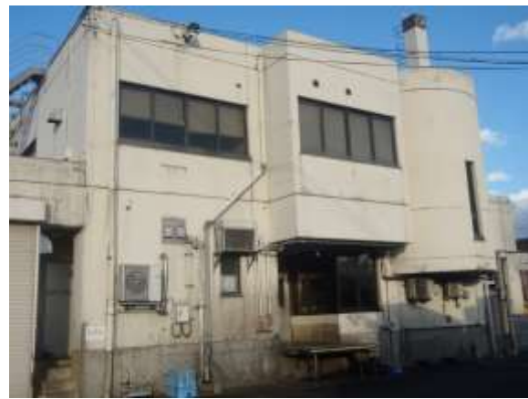
と畜場棟外壁
