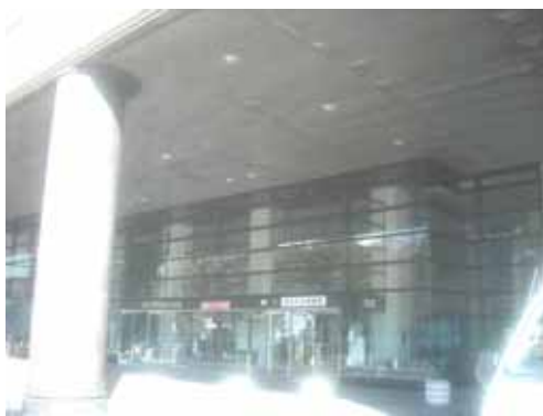
総合会館ピロティ天井崩落対策工事
