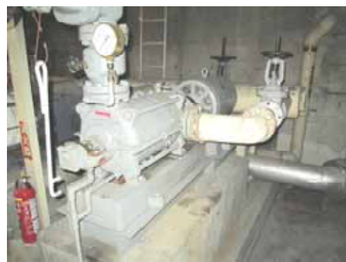
市庁舎消火ポンプ更新工事
