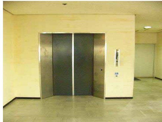
管理棟昇降機1階外観
