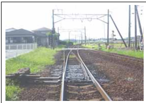
保々駅の重軌条化予定箇所
