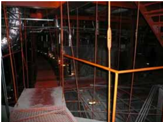
第1ホール客席天井裏状況
