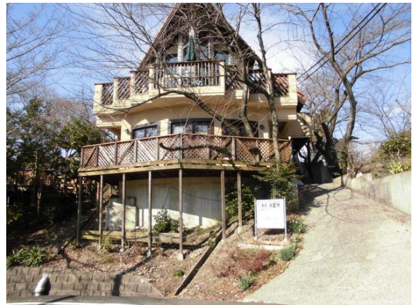
(伊坂ダム休憩施設)
