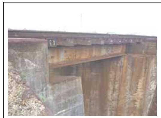
富田第三架道橋橋梁補修予定箇所
