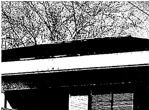
農業研修センター屋根
