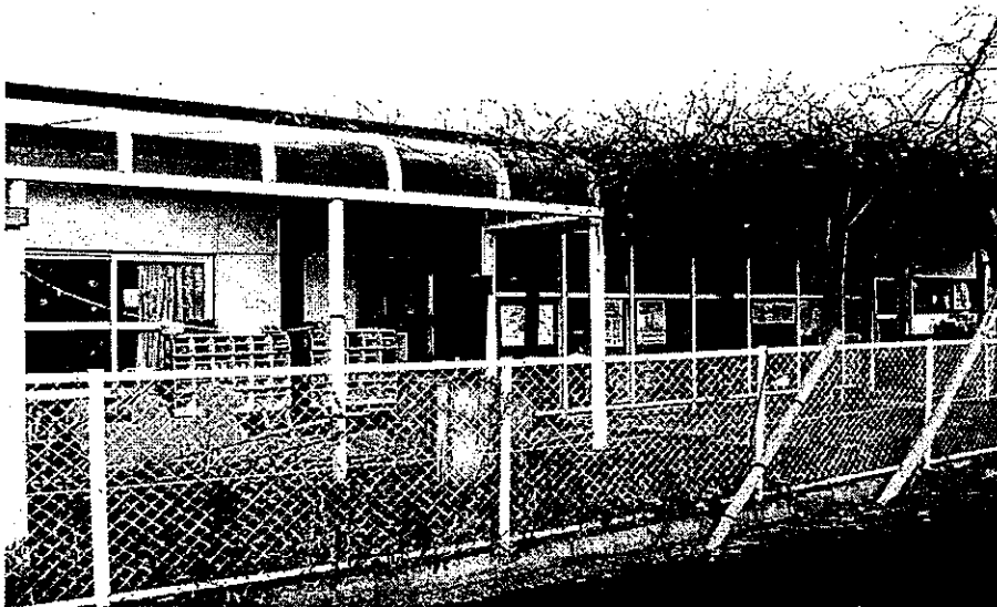
〔四日市厚生会保育園 現園舎〕
