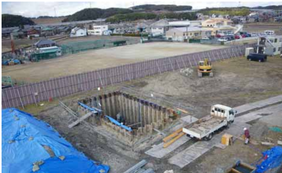
朝明水源地下紫外線処理施設建設工事
