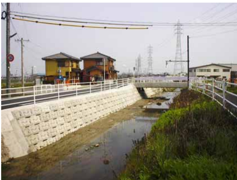
準用河川米洗川築堤・護岸
