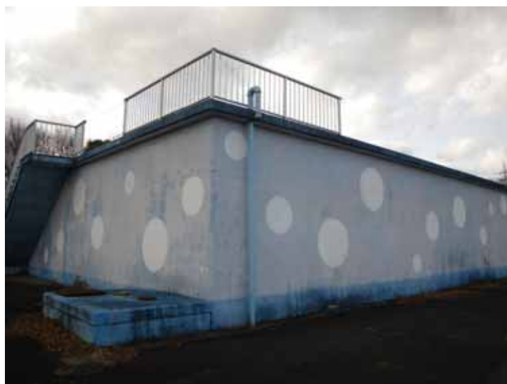
あかつき台配水池
