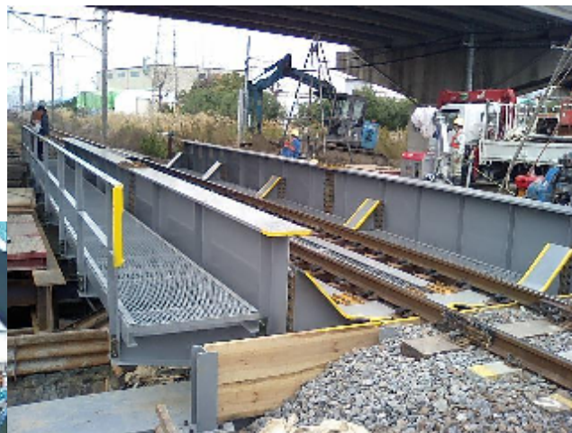
雨池雨水7号幹線水路 JR 横断施工状況 （下：水路横断部分 右：線路仮桁設置状況）
