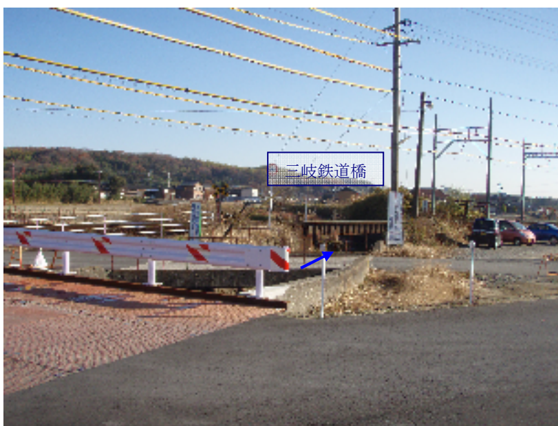
準用河川萱生川三岐鉄道橋及び市道橋
