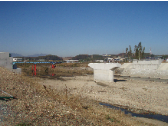
山村平津線 南から望む（朝明川橋梁下部工）
