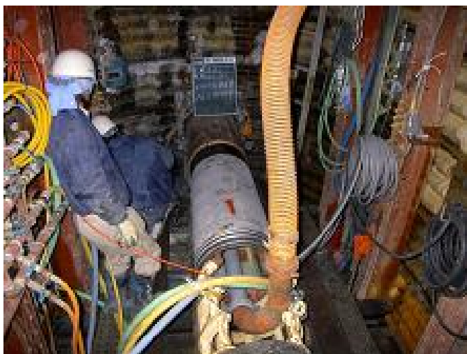
汚水管渠布設工事（立坑内での汚水管推進状況）
