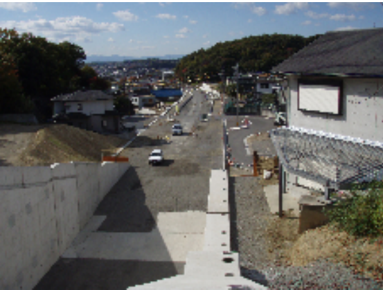
環状1号線 北から望む（整備中）
