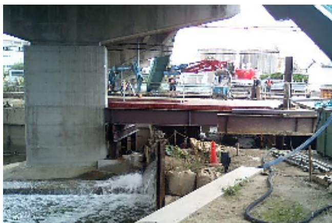
雨池雨水7号幹線水路 JR 横断施工状況 （下：水路横断部分 右：線路仮桁設置状況）
