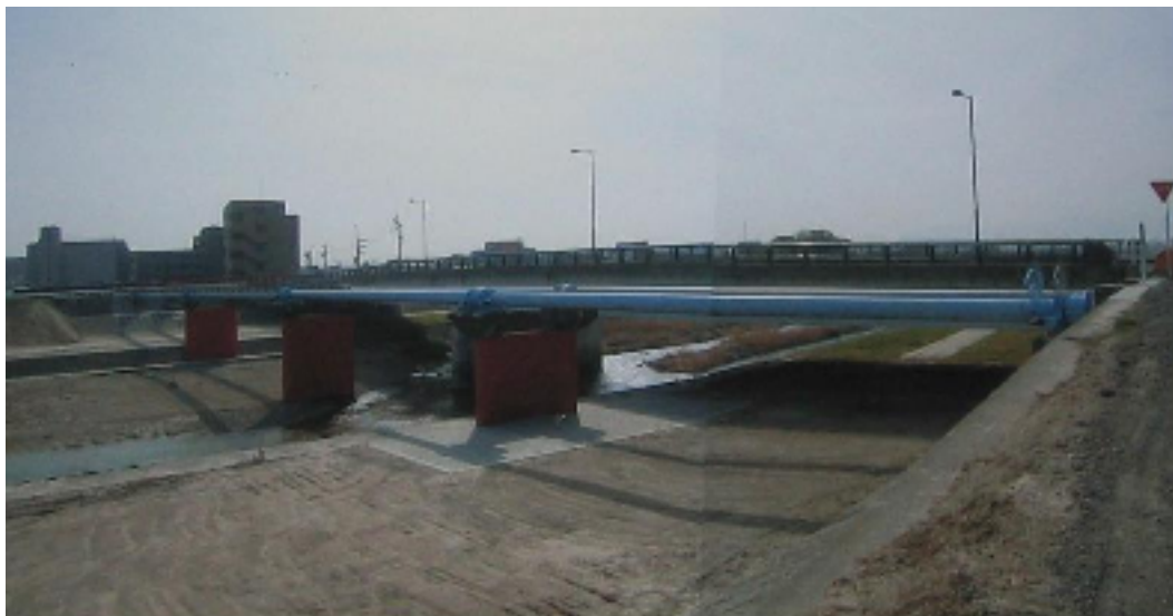
野田橋水管橋
