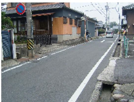
日永4丁目町地内（工事前）
