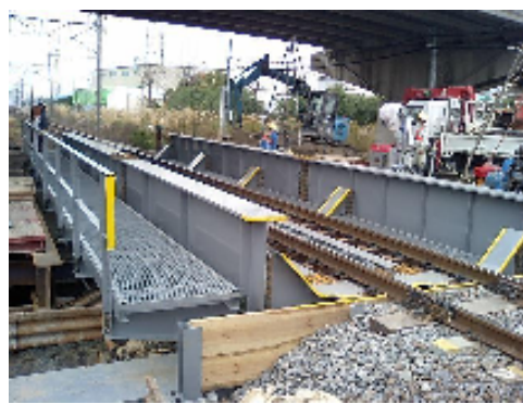
▲雨池雨水7号幹線水路 JR 横断施工状況 (線路仮桁設置状況)
