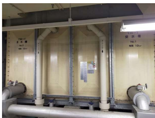
市庁舎受水槽更新工事
