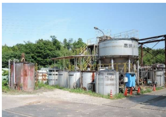
北部埋立処分場旧浸出水処理施設
