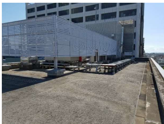
市庁舎北館屋上防水等改修工事
