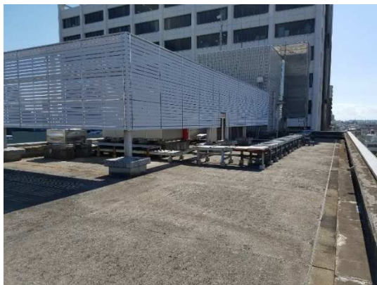
市庁舎北館屋上防水等改修工事
