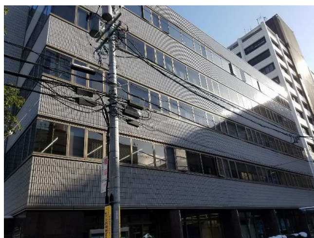
市庁舎北館外壁改修ほか工事設計業務委託
