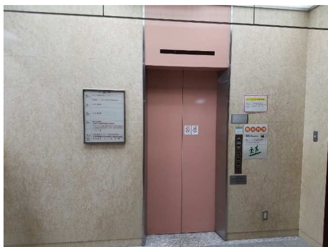
市庁舎北館エレベーター更新工事
