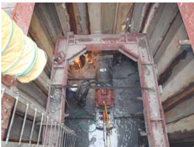
茂福汚水1号幹線管渠布設工事
