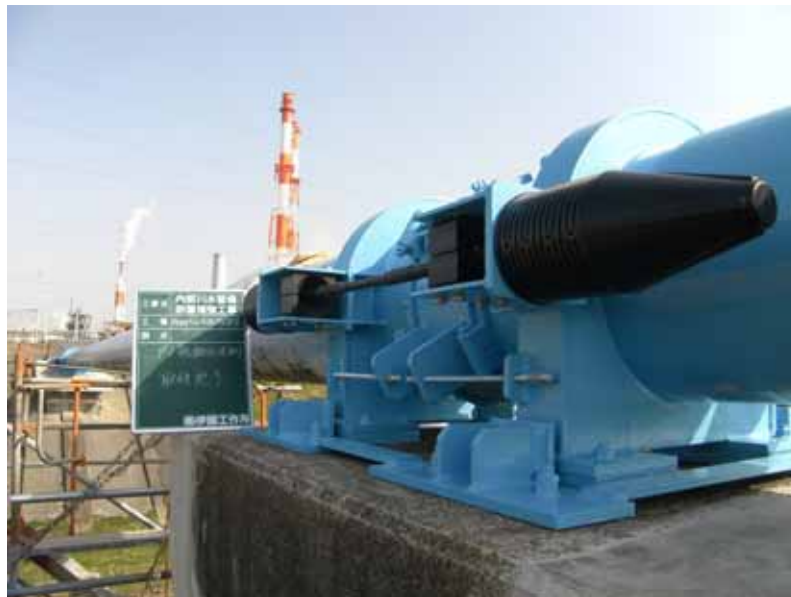
水管橋補強工事
