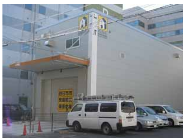
防災備蓄倉庫（安島）
