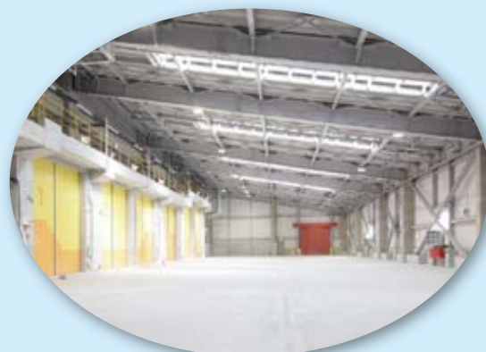
プラットホーム(ごみ搬入口)
