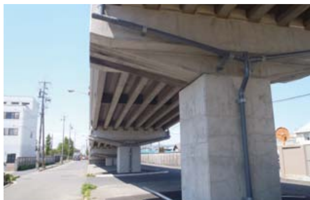
耐震工事の完了した跨線橋の橋梁(馳出町)
