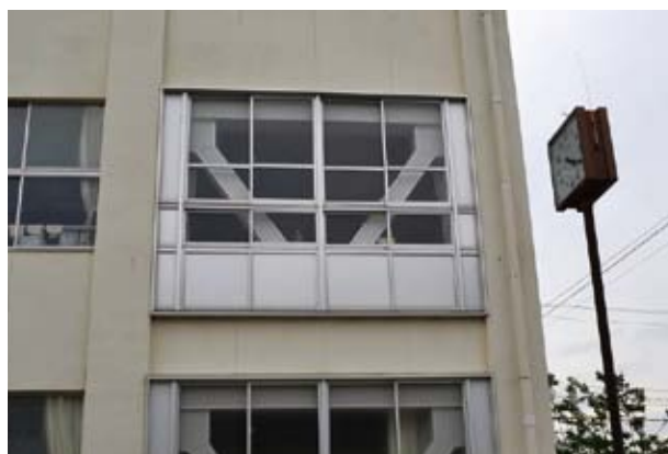
耐震補強された校舎(羽津小学校)
