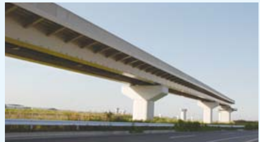
建設が進む臨港道路霞4号幹線
