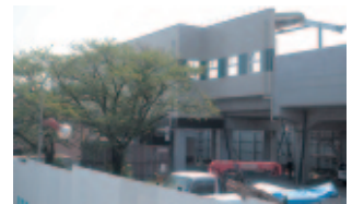
高架化中の近鉄川原町駅
