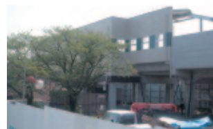
高架化中の近鉄川原町駅
