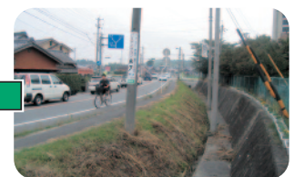
危険だった県小学校の西側
