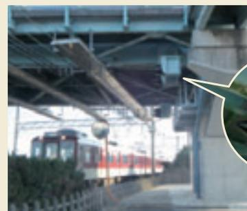
落橋防止装置を取り付け耐震化 (馳出町)
