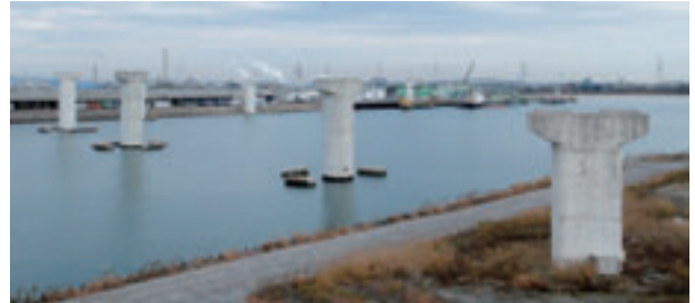
建設が進む霞4号幹線
