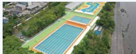
◀改修した霞ヶ浦プール
